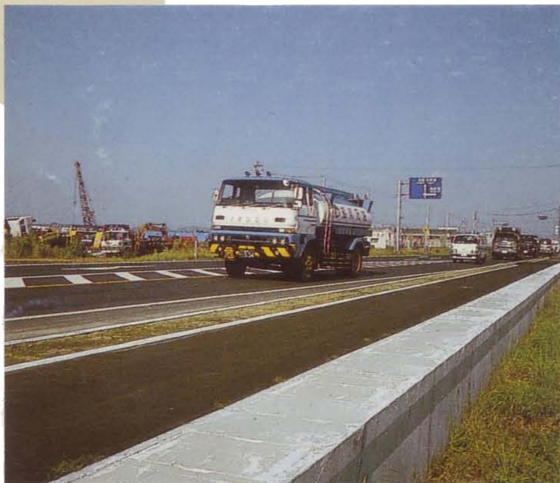
道路拡幅工事
