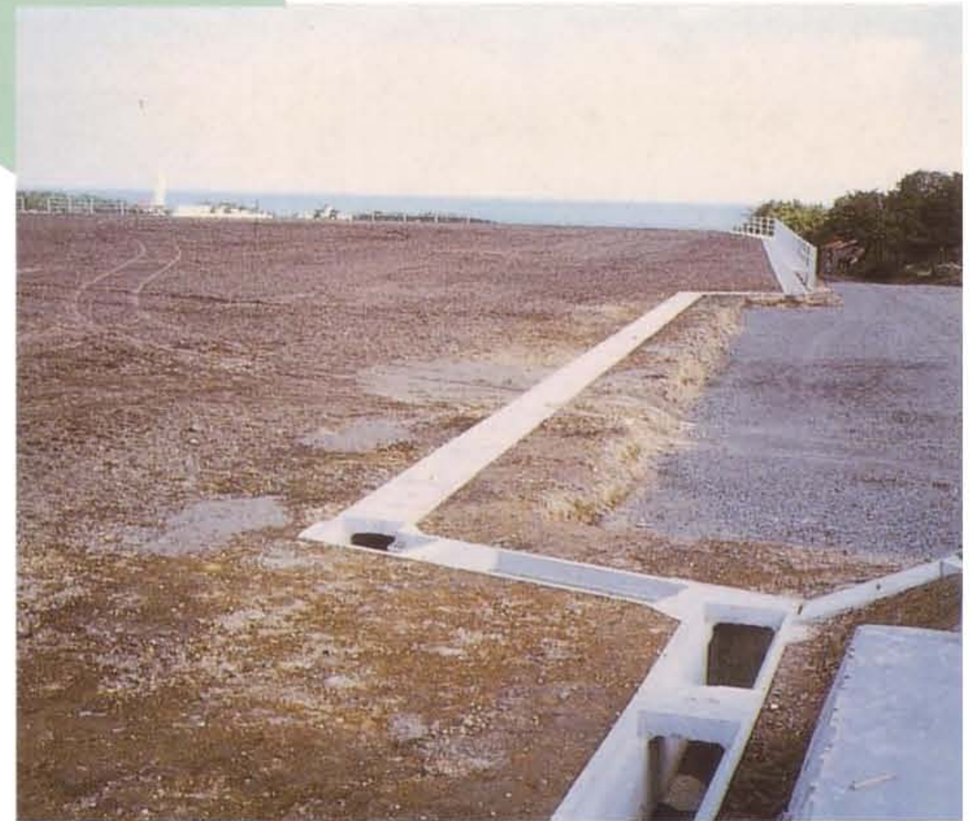
港湾背後地整備
