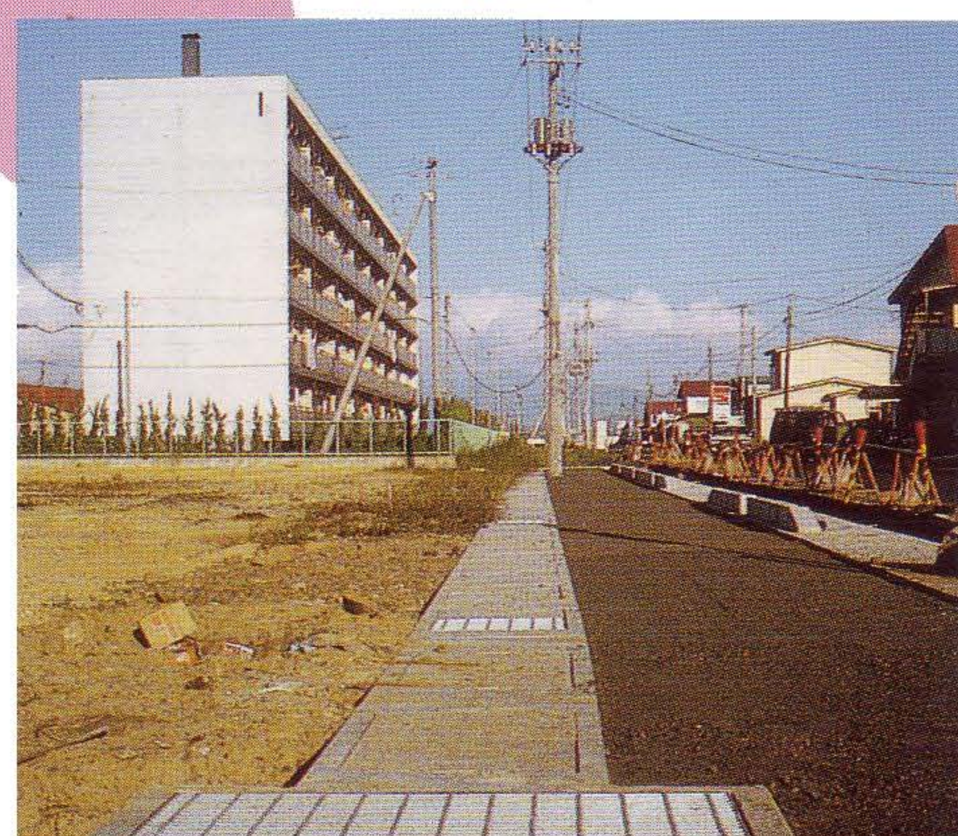
ニュータウン宅地造成
