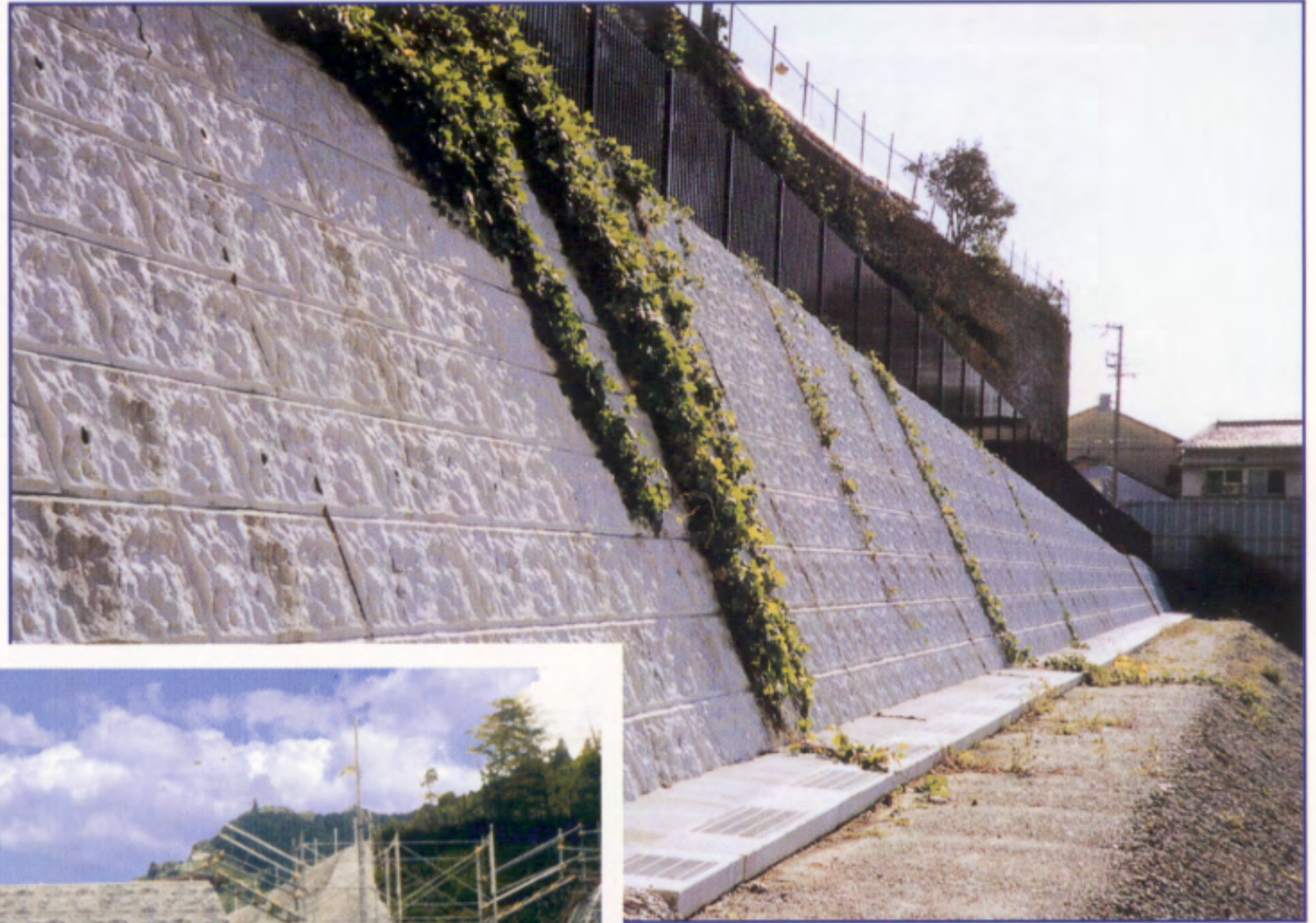
兵庫県：名倉小学校敷地整備工事
