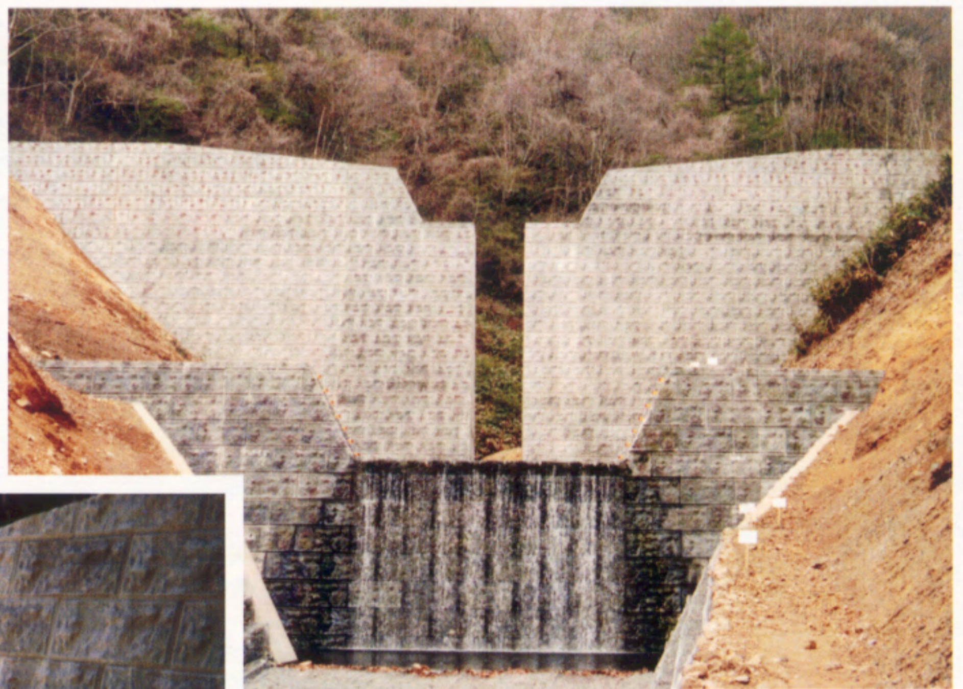
岩手県: 滝ノ沢筋滝ノ沢砂防堰堤工事
