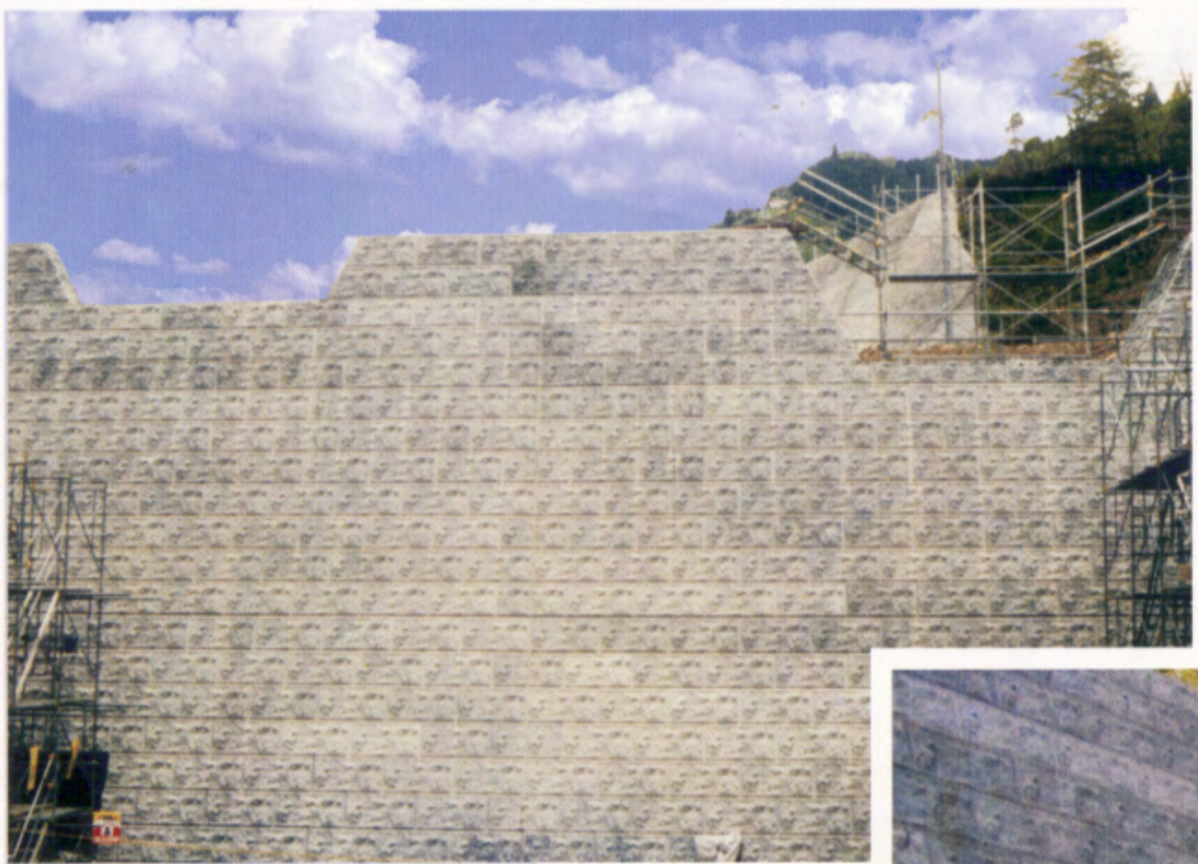
静岡県：第二東名 清水第四トンネル工事
