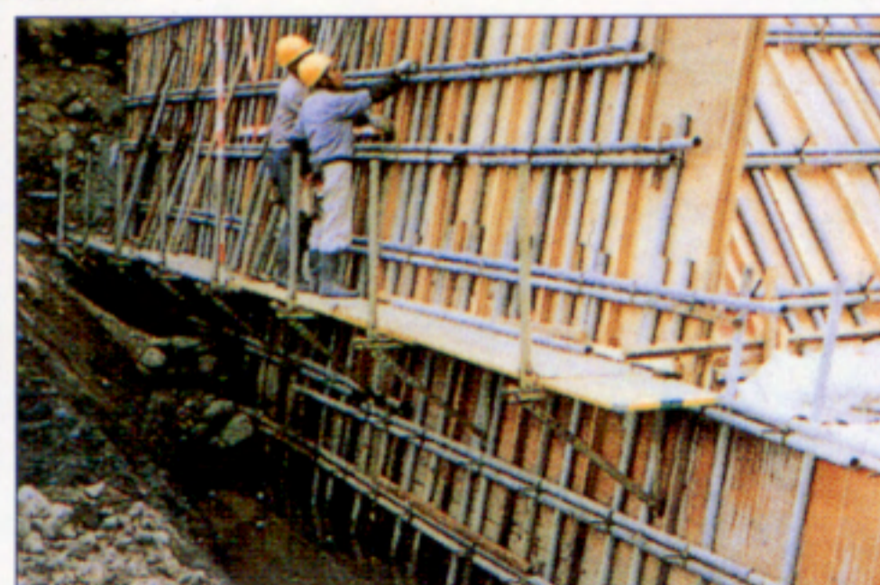
② 従来工法(合板型枠の仮設)
