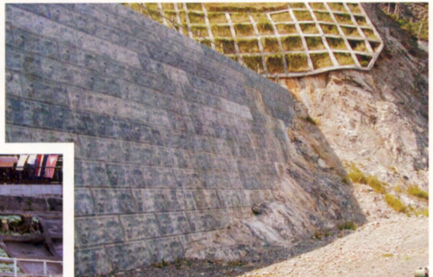
北海道：一般国道336号襟裳町迂遠別トンネル工事
