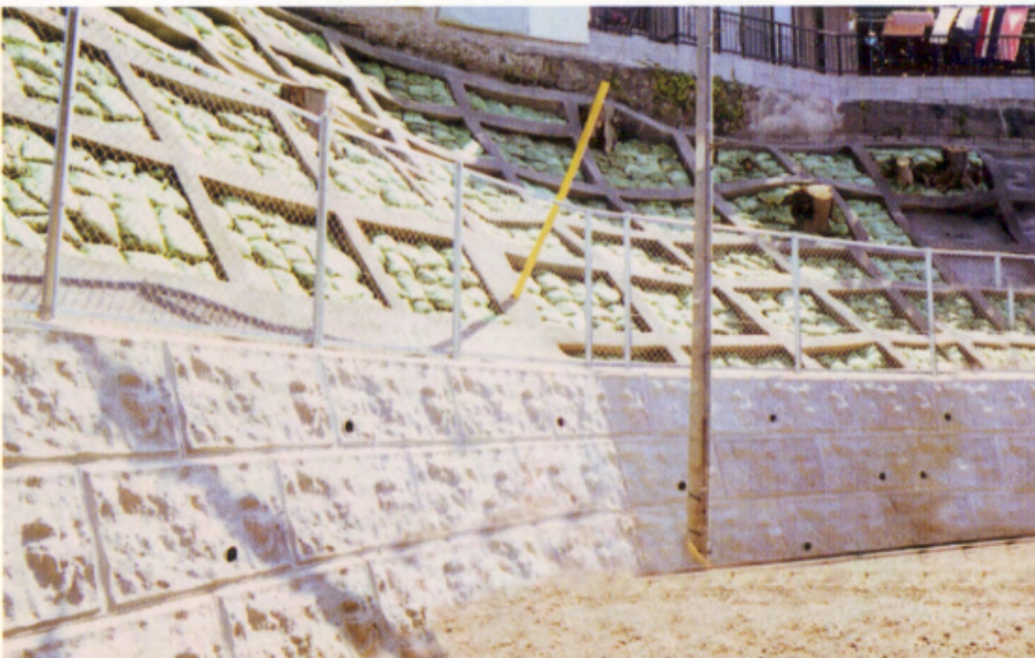
神奈川県：急傾斜地崩壊対策事業
